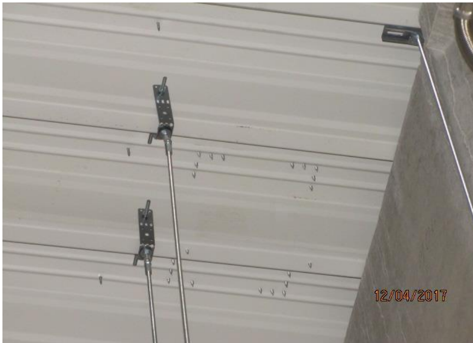
Foto 10 - Sichtprüfung von unten
