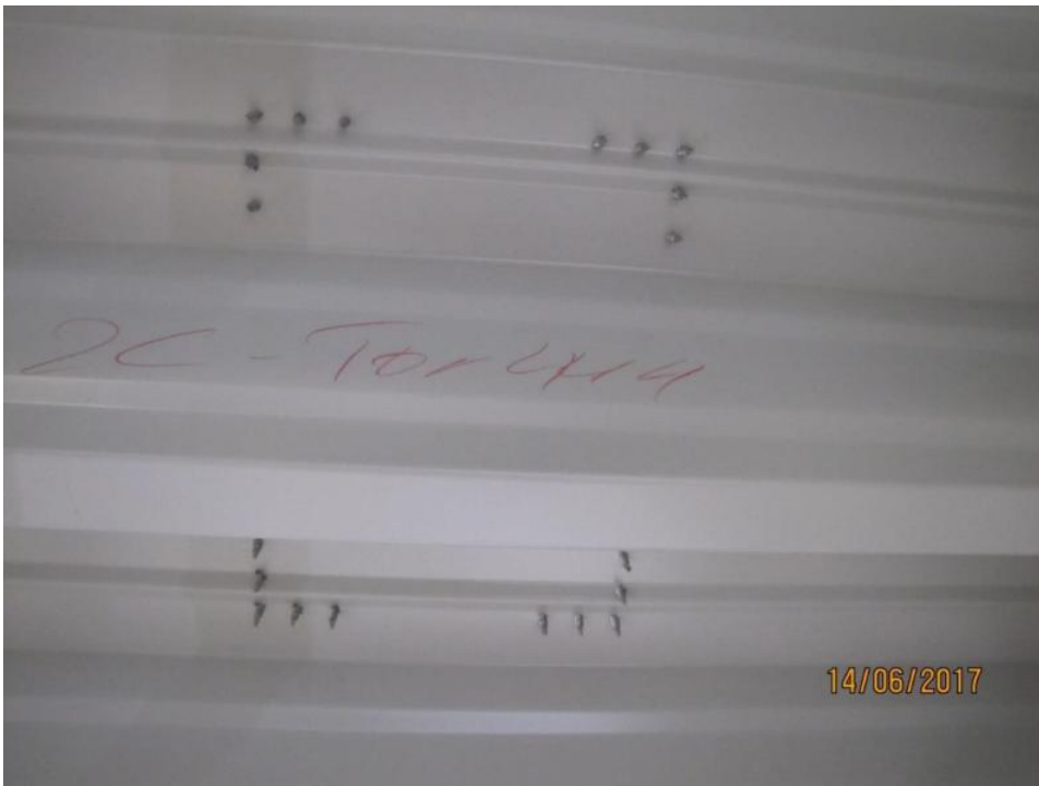
Foto 8 - Sichtprüfung von unten
